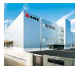
守谷工場 医薬・産業資材棟
