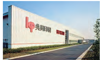
太陽光発電設備導入予定の五霞工場
