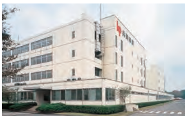
空調システムを更新した鶴ヶ島工場
