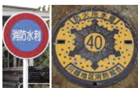
「消防水利標識」と「防火水槽」
