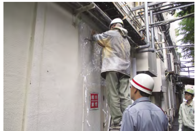
廃液の配管破損を想定した訓練
