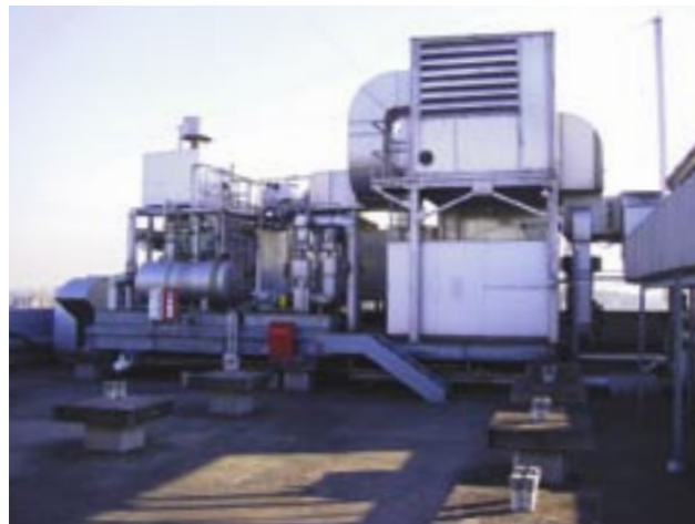
排ガス処理装置（守谷工場）
