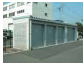
廃棄物置場 (川島工場)
