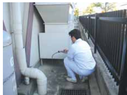
ガス検知管による測定(小田原工場)
