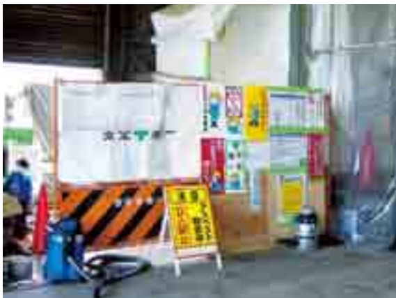
アスベスト処理（越谷工場）
