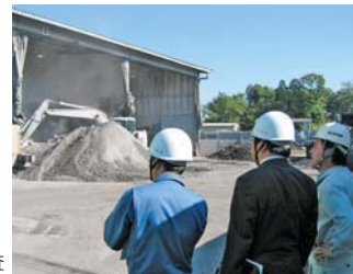
最終処分場の立会い検査
