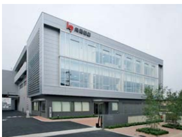
高セキュリティを実現した京都工場
