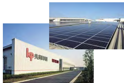
五霞工場の1号館(左)と設置が進む太陽光発電設備
