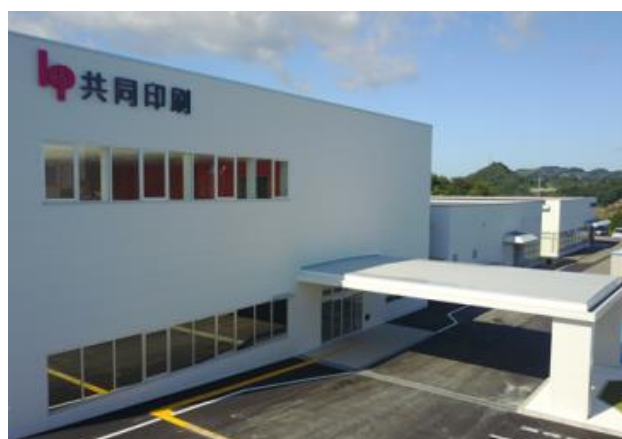
3号館竣工後の和歌山工場(左手前が3号館)
