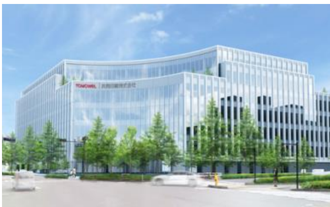
竣工後の共同印刷(株)本社 [イメージ]
