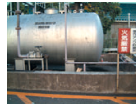
燃料タンク防油堤（鶴ヶ島工場）
