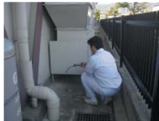
ガス検知管による測定（小田原工場）
