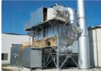
写真2 VOC 排出処理装置 (常磐共同印刷)
